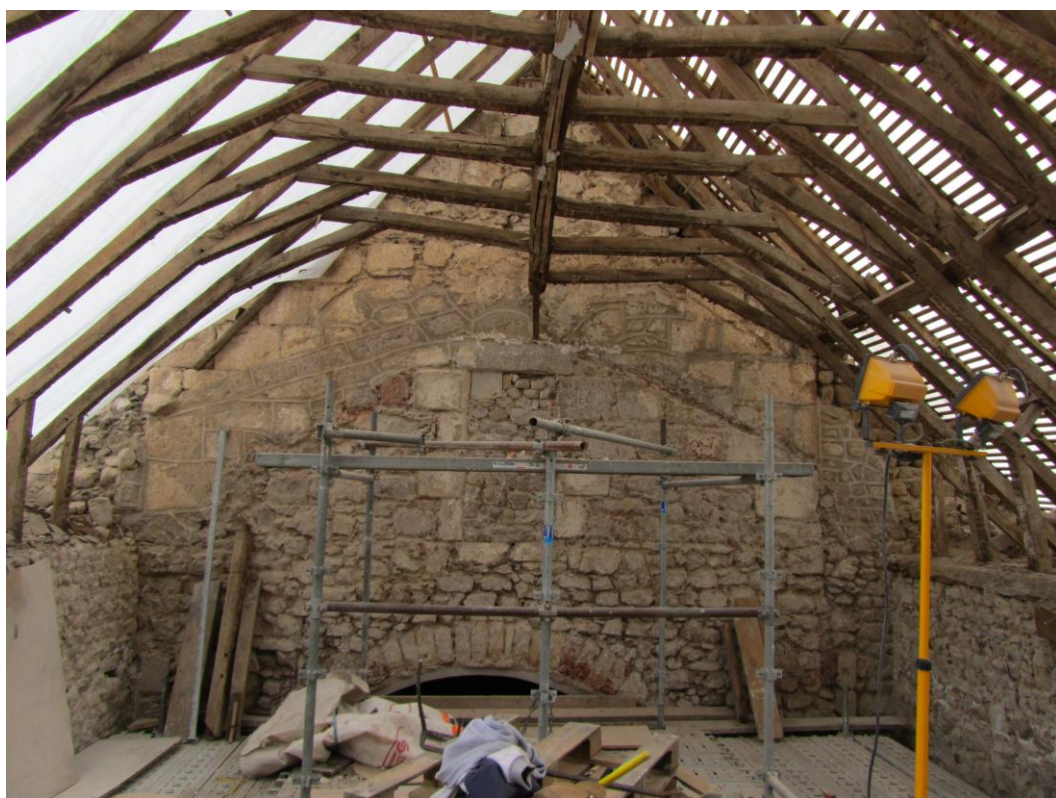
Dépose de la toiture
