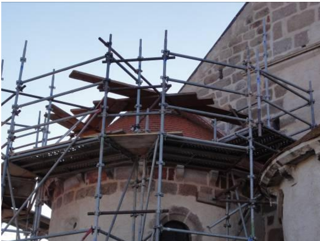
Couverture d'une tour
